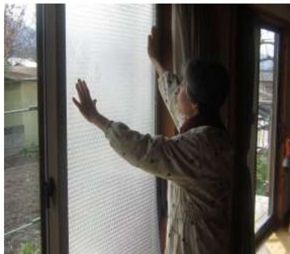
窓に断熱シート
