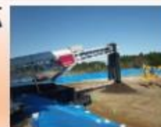
中間貯蔵施設 土壌貯蔵施設
