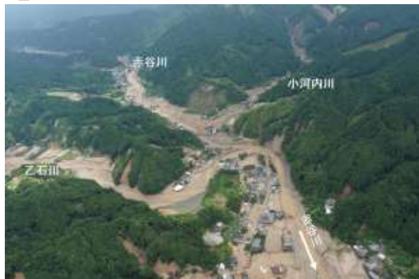
図21 2017年の九州北部豪雨による被害（福岡県朝倉市の赤谷川、小洞内川、乙石川合流点付近における流木による被害） 出典19より
